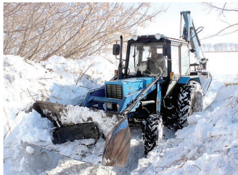
Идет очистка водоотводного канала в с. Бочанихе.
