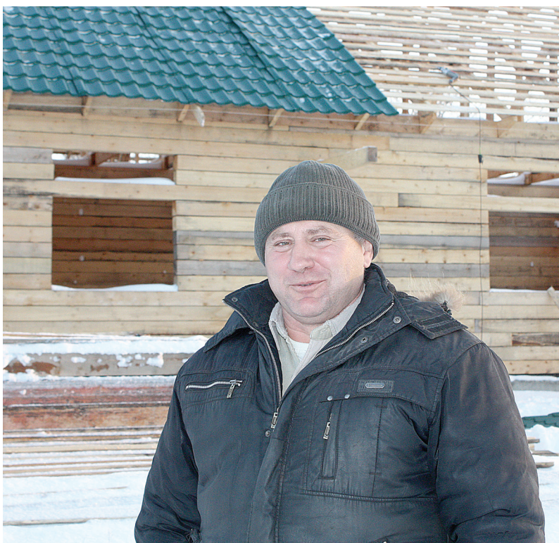
Алексей Кузьменко у строящегося дома.
