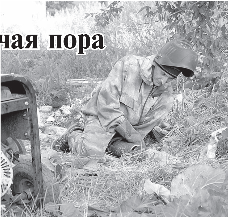
Неполадки в теплотрассе устраняет сварщик МУП «Тепло» Андрей Аношкин.
