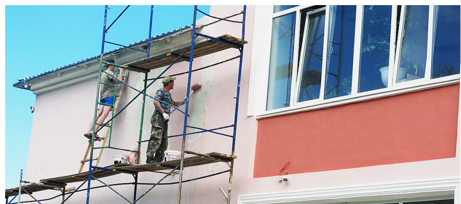
Ремонт фасада РЦК.
