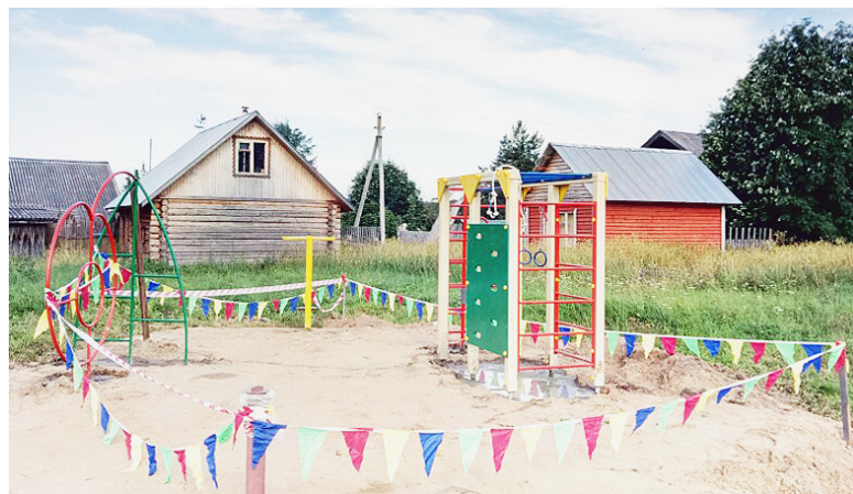
Строящаяся детская площадка в деревне Олеховской.
