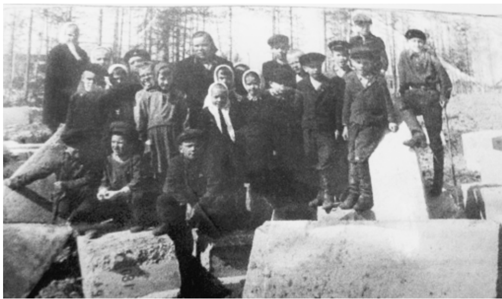
Закладка фундамента школы.
