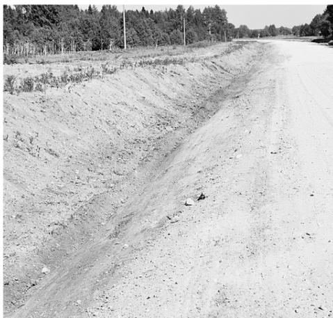
На автомобильной дороге Сямжа - Харовск ведутся работы по исправлению поперечного и продольного профиля проезжей части с добавлением нового материала. Также производится прочистка водоотводных канав и срезка кустарников. По словам директора Сямженского ДРСУ филиала ПАО «Вологдавтодор» Евгения Киселева, на сегодняшний день оканавливание сделано на участке продолжительностью одиннадцать километров. В течение лета работы будут проведены на протяженности всей автодороги.
