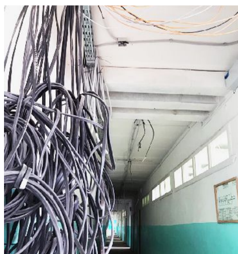
Монтаж электропроводки в коридоре
