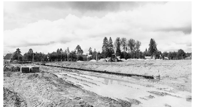
В настоящее время готовится основание большого поля, беговой дорожки и стоянки около стадиона, установлены опоры сеткоуловителей, ведется ремонт трибуны.
