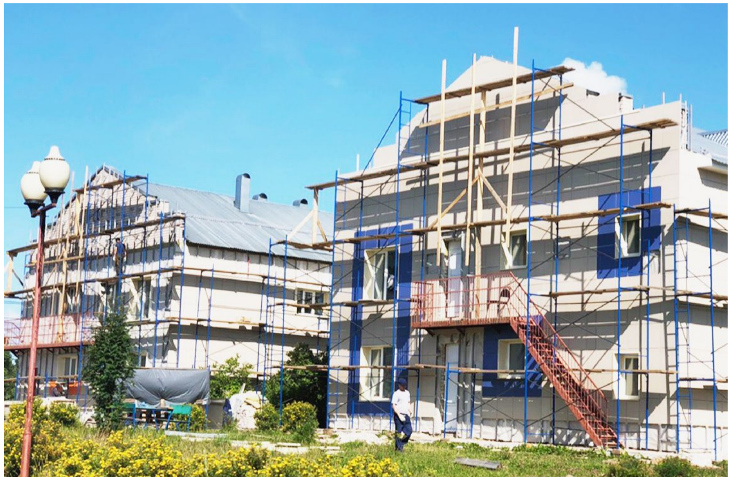
Рабочие приступают к ремонту лицевой стороны здания.
