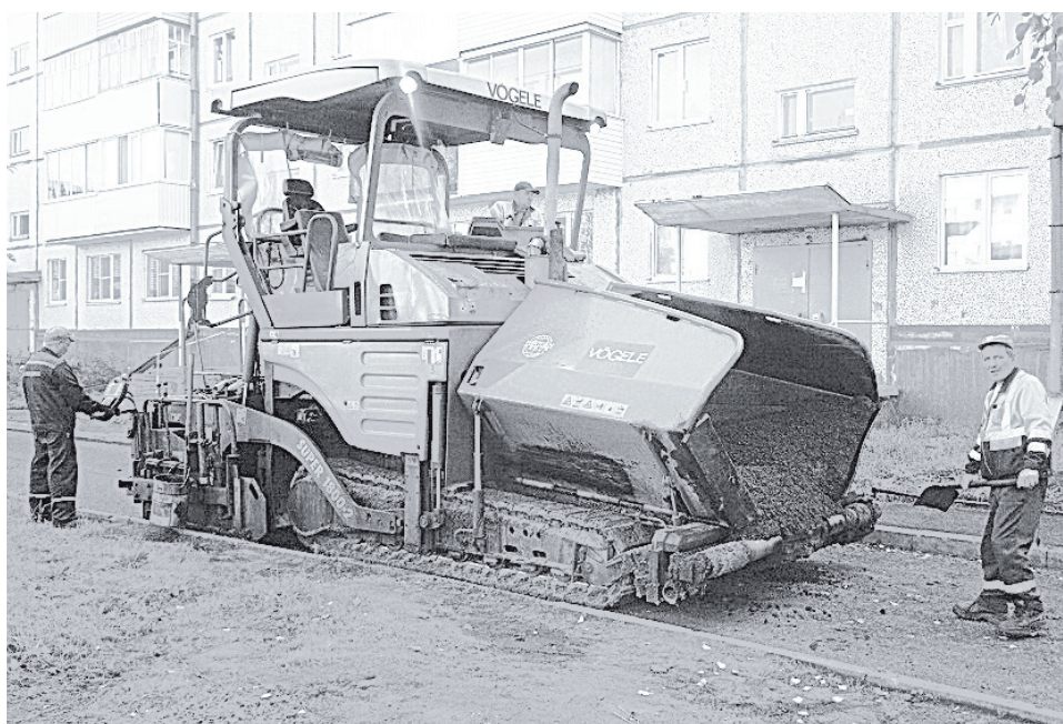
Асфальтирование территории у дома Октябрьская, 19 в Холмогорах. Гарантия — пять лет, дорожники утверждают, что покрытие прослужит дольше. Фото Жанны Космыниной.
