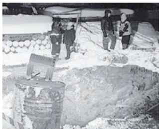
Причиной аварии стали коррозионный износ и усталость металла - трубопроводам более сорока лет. Устранение аварии осложнялось тем, что трубы заложены на глубине 5,5 м. Также затрудняли работы сложные грунты и заболоченная местность.
