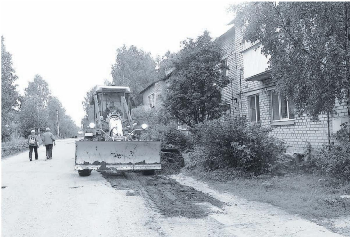
**Рабочие достали из дорожного полотна более ста столбиков и кусков брёвен и откопали тротуары из плит. Слой земли на них был такой, что загрузили и увезли четыре КамАЗа грунта**
