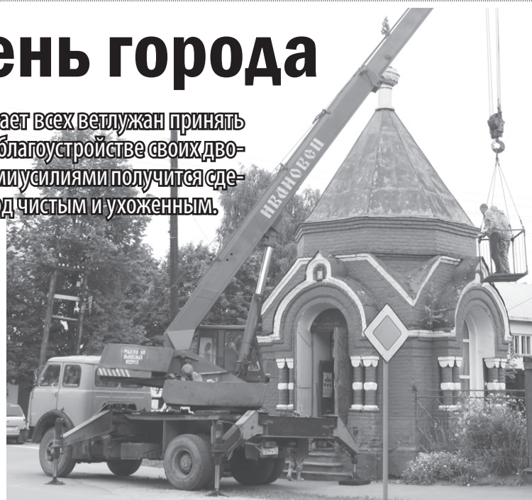
■ Начался ремонт фасада часовни Александра Невского в г. Ветлуге.
