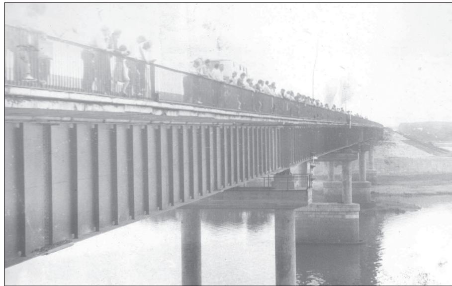
Мост через р. Ветлугу открыт
