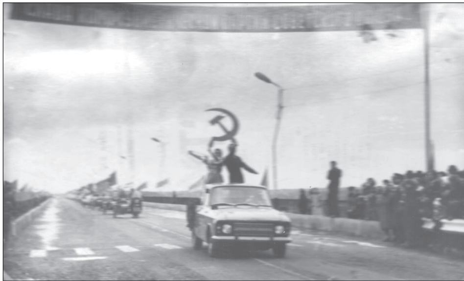
Машины идут по новому мосту
