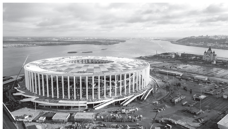
■ Завершён монтаж кровли на стадионе «Нижний Новгород». ФОТО ПРЕДОСТАВЛЕНО АВТОРОМ
