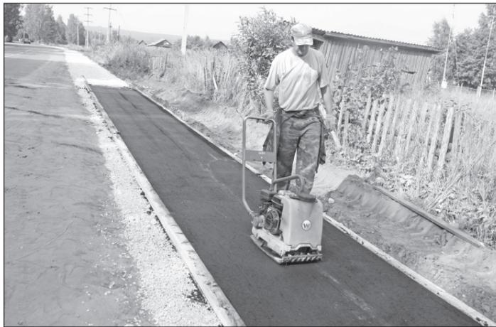
■ С. Замышляев уплотняет асфальтобетон виброплитой. ФОТО: НАТАЛЬЯ ТОРОПОВА, «ЗЕМЛЯ ВЕТЛУЖСКАЯ»
