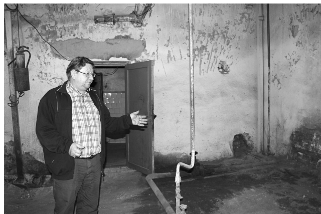
• А.В. Чашкин рассказывает о ремонте в котельной.
