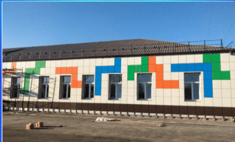
О важном Капитальный ремонт СИУТ продолжается
