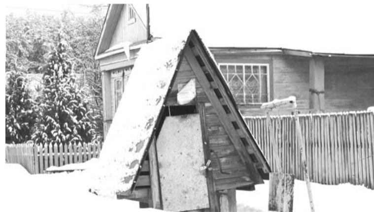
Ремонт колодца стоит в «плане»
