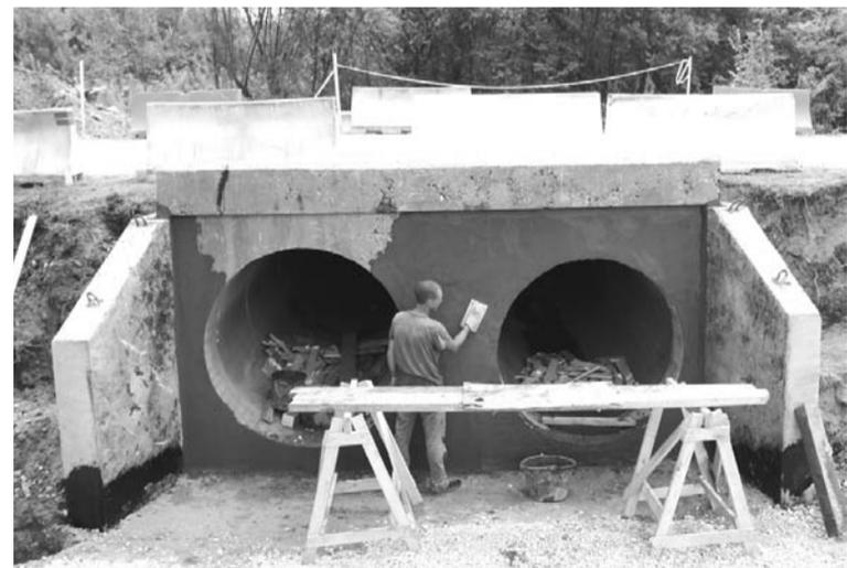
но сформировались. В комплекс работ входило устройство трубы и укрепление армированным бетоном. На выходной части устроили «ковш размыва» - небольшие ямы, заполненные крупными камнями, чтобы выходящие потоки воды не разрушали грунт. Для более эстетичного вида рабочие покрасили вход и выход труб в белый цвет. После всех работ на этих участках дороги восстановили ас-
