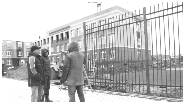
Одновременно ведутся монтаж школьной ограды и благоустройство
