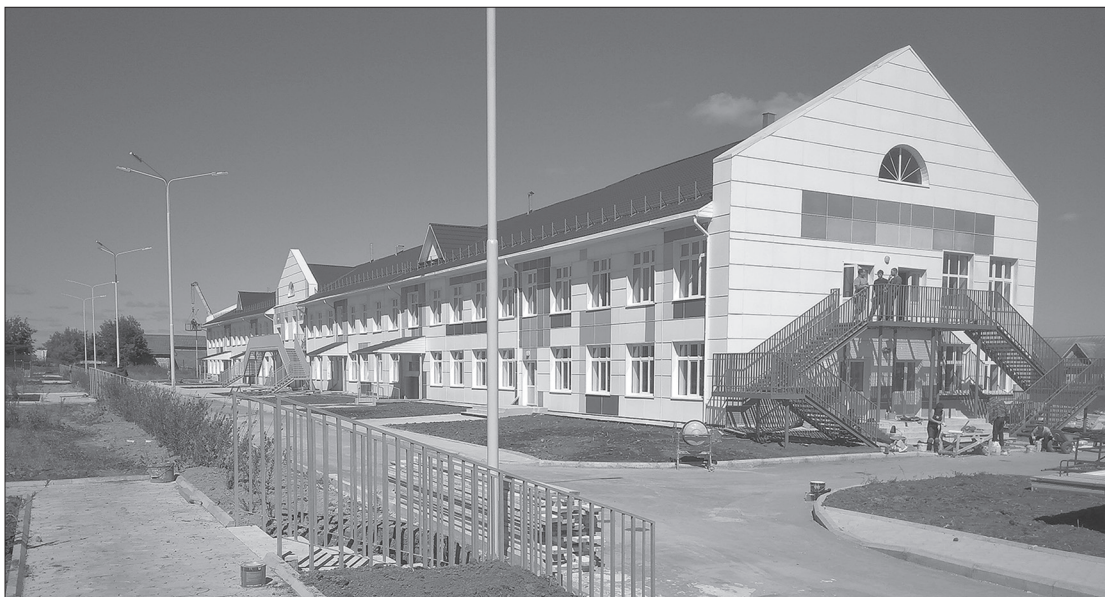
Реконструкция здания школы под детский сад, завершение близко
