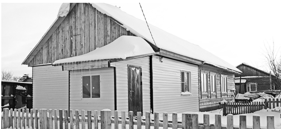
Отремонтированный муниципальный жилой дом.
