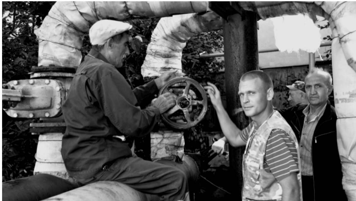
Бригада котельной №1 на ул. Чапаева проводит плановую подготовку к отопительному сезону (на фото слева направо слесари В.А. Рябов, В.О. Катков, Н.В. Емельянов (на заднем плане) и начальник котельных Н.В. Свечников).
