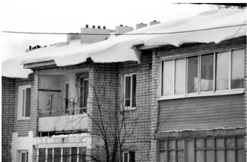
Ул. Шоссейная, д. 64. Обслуживает ООО «Жилсервис».
