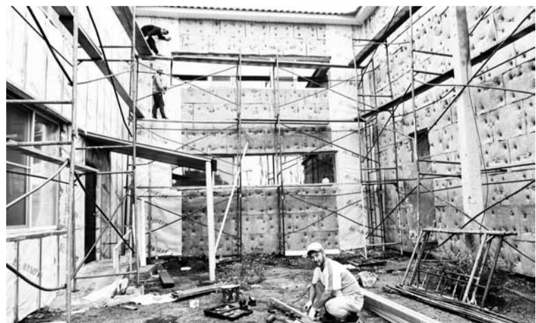
В дошкольном учреждении «Журавушка» посёлка Ленинский к сегодняшнему дню выполнены 40 % запланированных работ
