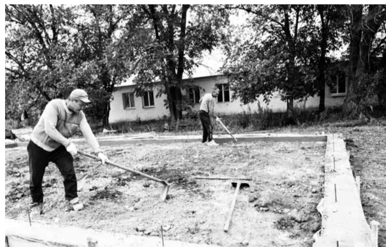
В настоящее время в посёлке Любичский заливается монолитный фундамент современного модульного ФАПа
