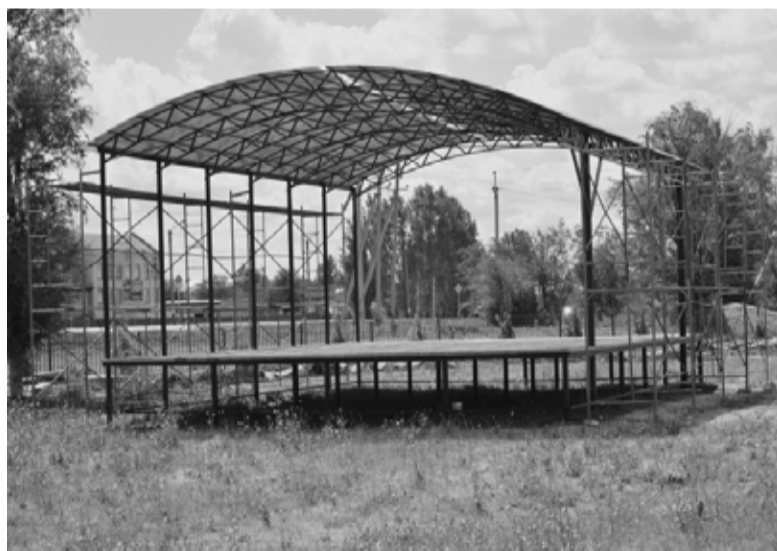
На новой летней эстраде в парке Победы смонтированы плиты перекрытия и кровля
