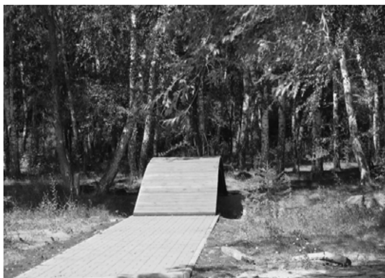
В парковой зоне, за обелиском, началось строительство «Моста влюблённых»
