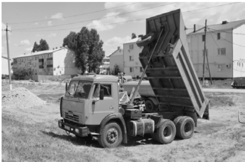
Подрядные организации ООО «МЗС» и ООО «Строй Лад» обустривают придомовые территории многоквартирных домов
