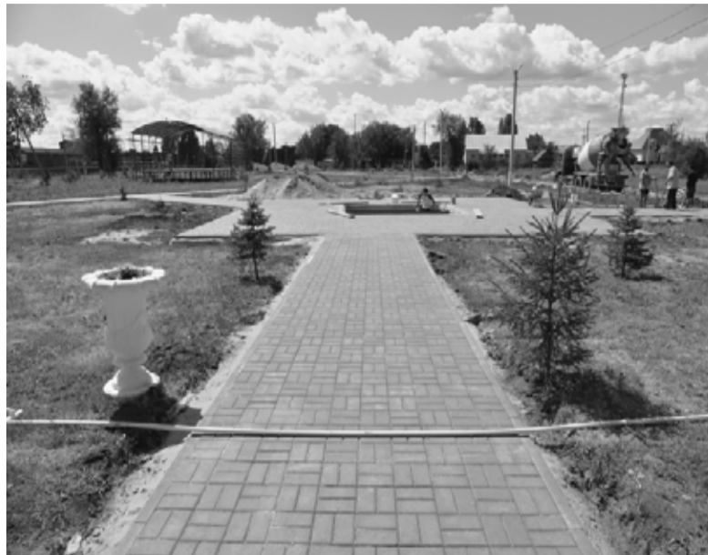
Пешеходная дорожка к фонтану Парка Победы выложена плиткой
