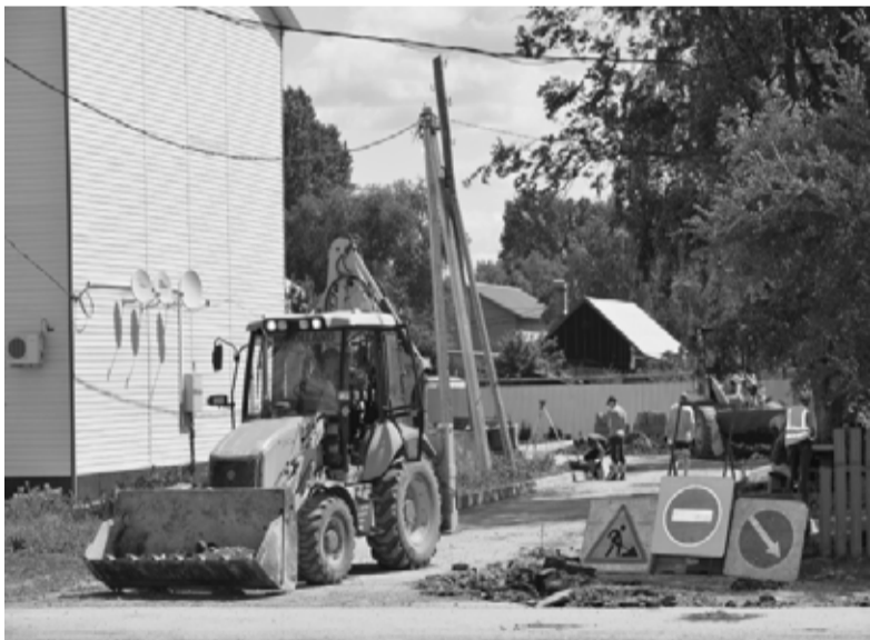
На фото строительные работы во дворе домов по ул. Шоссейная, 44 и ул. Шоссейная, 46
