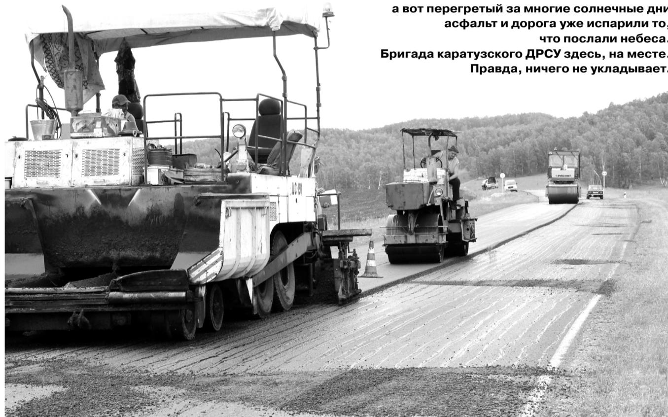
Устройство покрытия из асфальтобетона на автодороге «Кочергино-Каратузское». Старое полотно подготовлено под укладку: ямы заделаны, для лучшего примыкания и сцепления слоев на стыках выбрана фрезой канавка, выполнена подгрунтовка битумом
