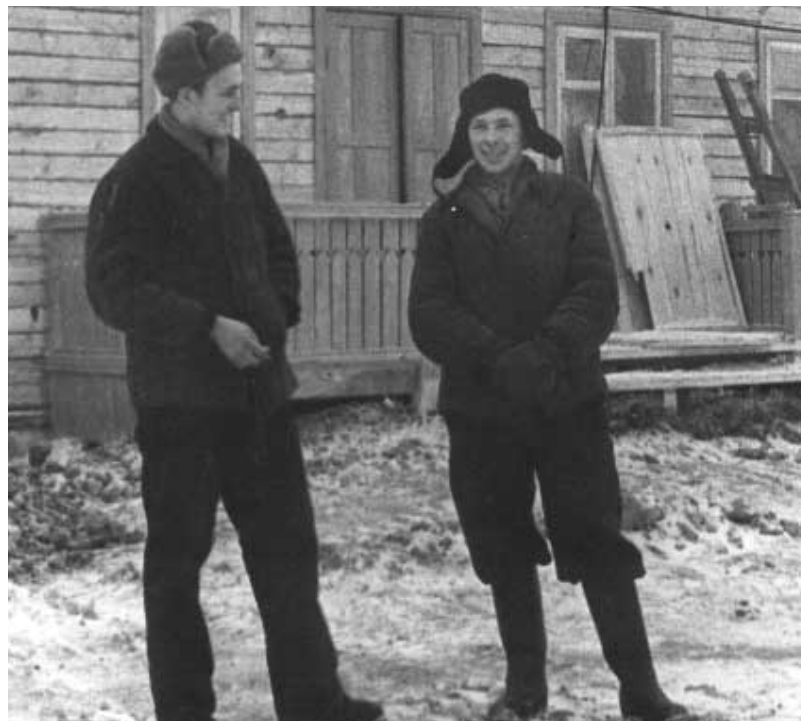
С. Ключников (слева) и В. Погребной, бригадир комсомольско-молодежной бригады, на строительстве Красноярской ГЭС
