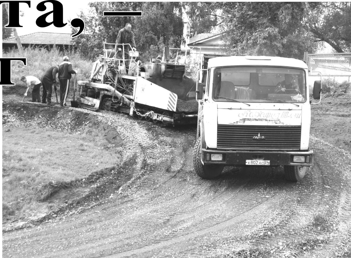
Крутой вираж на строительстве лыжероллерной трассы
