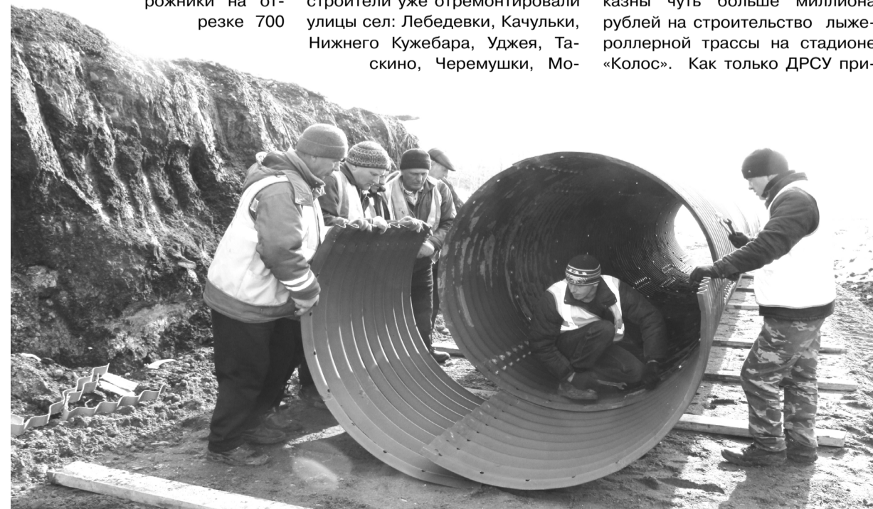
Идет сборка гофрированной водопропускной трубы
