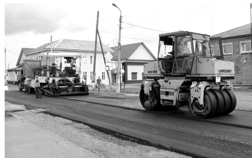
Ремонт улиц в Каратузе
