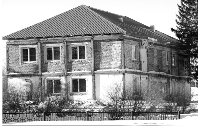
Реконструкция здания под детский сад в Таскино
