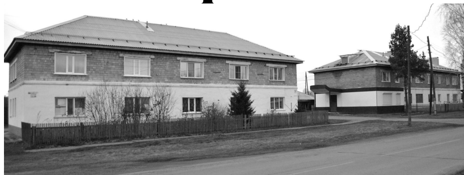
Улица Пушкина, дома № 25 и 27 после ремонта
