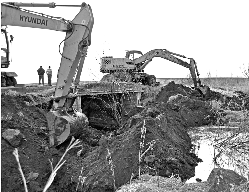
Перекрытие р. Черемушки в районе второй бригады
