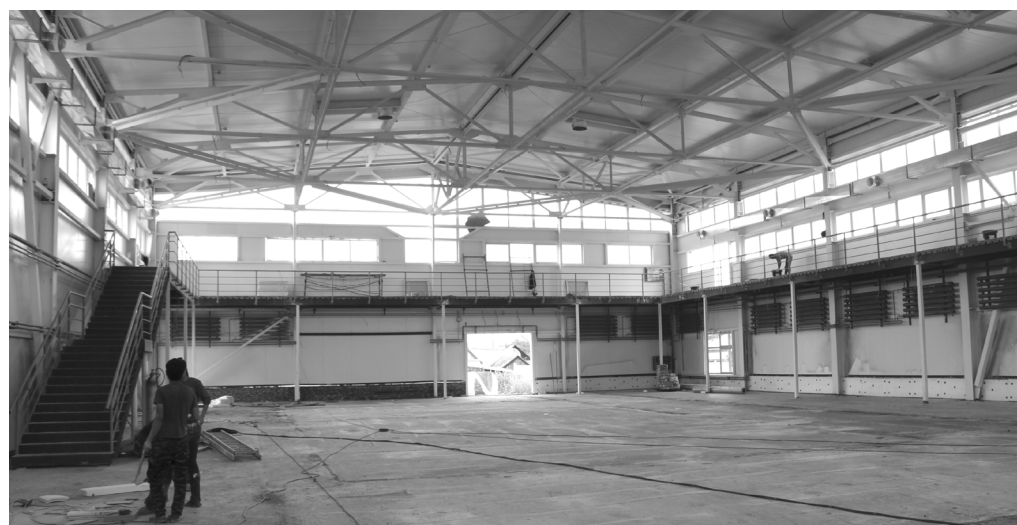
Идет внутренняя отделка спортзала
