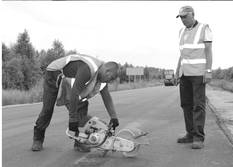
Спустя трое суток после укладки асфальтового покрытия через каждые 300 погонных метров специалисты ДРСУ делают вырубку для лабораторных исследований
