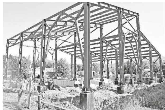
Каркас будущего спортзала в Таятах
