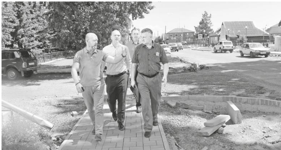
Осмотр хода выполнения работ по благоустройству улицы Советской районного центра
