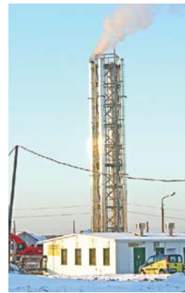
Котельная-новичок со стороны
