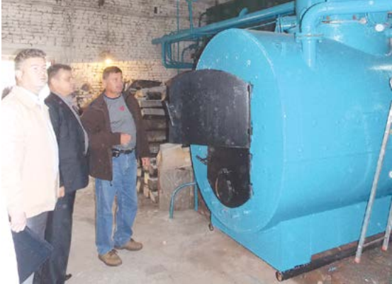
На котельных ЗАО "ТЭКУР"
