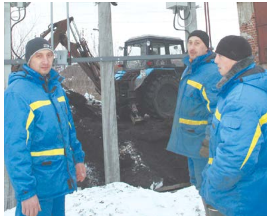
Подготовительные работы на РП-5. Слева мастер А.Гилязов
