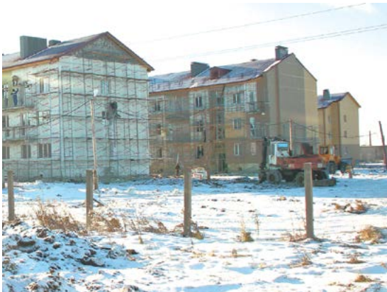
Строительство четырех домов на ул.Колногорова идет полным ходом
