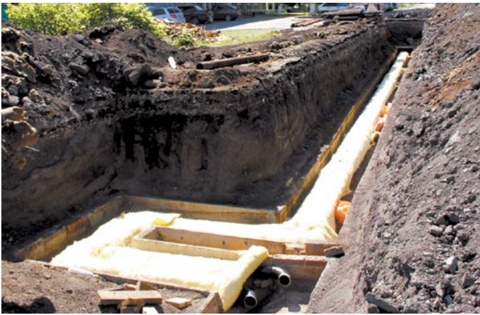
В июле завершен капремонт теплотрасы по улице Р.Люксембург
