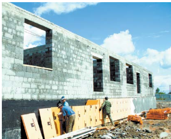
Идет строительство нового детского сада
