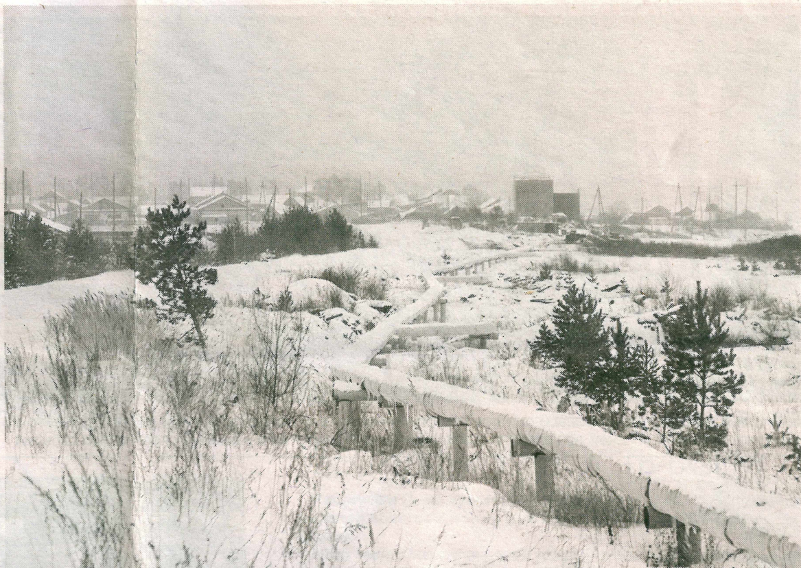
Теплотрасса до Ангарского
