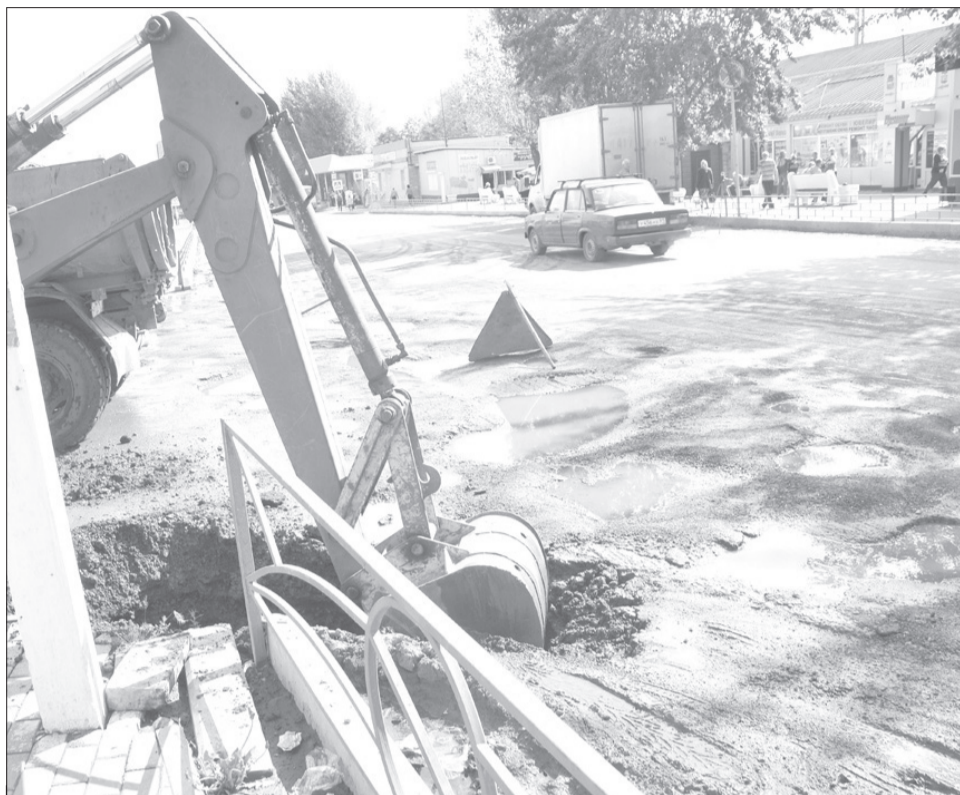
7 мая коммунальщики выкопали котлован для откачки грунтовых вод.
