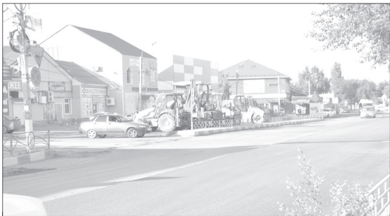
Ремонт городских дорог еще не окончен.
