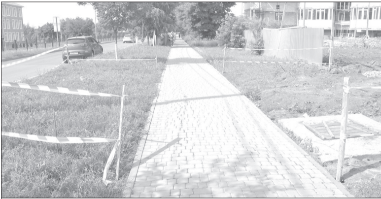
Подрядчик демонтирует тротуарную плитку, после чего восстановит покрытие.
