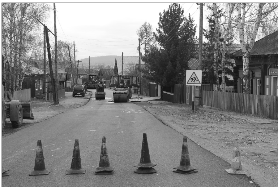
В два слоя уложен асфальт на улице Ленских Событий
