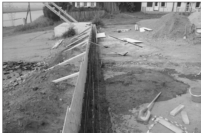
Прилегающую территорию выравнивают до уровня подпорной стенки
