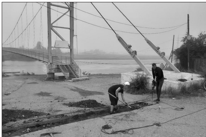
Ремонт начали с формирования подпорной стенки
