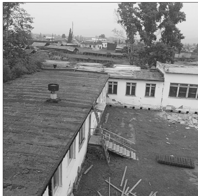
Работы в Манзурской школе ведутся снаружи и внутри, обновляется кровля, на третьем этаже заливают бетоном полы
