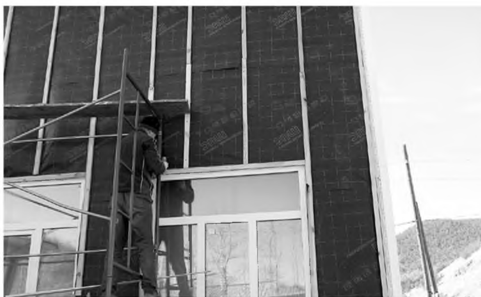
Сейчас в ДК полным ходом идут ремонтные работы
