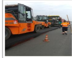
Технические характеристики развязки: общая площадь асфальтобетонного покрытия составляет 16 068 кв. м, площадь тротуара 4 147 кв. м, ширина проезжей части кольца составляет 11 м, диаметр кольца 51 м, тип
