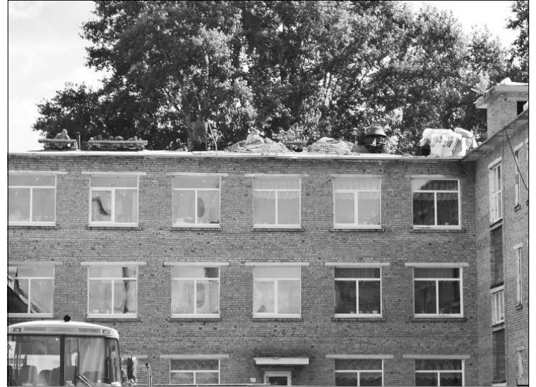
Ведутся работы на кровле Визингской школы.
