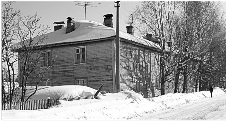
Дом 7 по ул. Мира ожидает ремонт.
