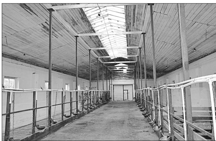
Отремонтированное помещение ждет своих постояльцев.
