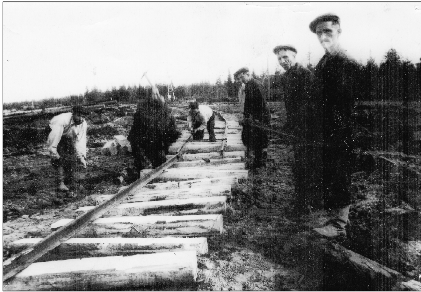
Бригада Асланова на укладке путей Сысольской УЖД.
