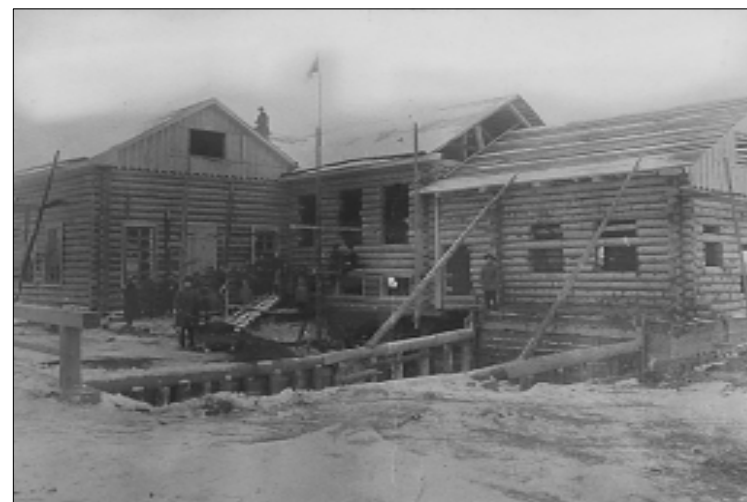
В стадии завершения механический цех и мельница (1935 г.).
