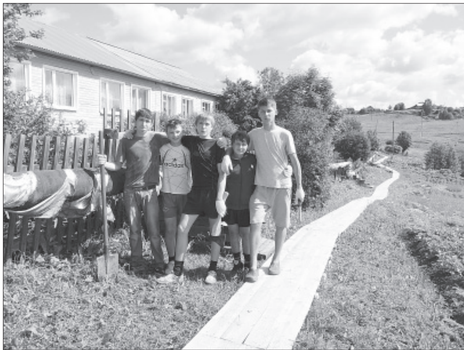
Участники трудовой бригады школьников на строительстве тротуара по ул. Октябрьской. Лето 2012 г.
